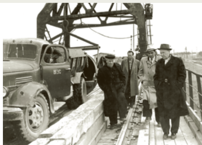
Фото В.А. Шипкова. Бетоновозная эстакада ГЭС (1961 г.). Комиссия (слева направо) – И.В. Кочетов, Л.М. Иванов, А.К. Икомасов, Н.В. Разин.
