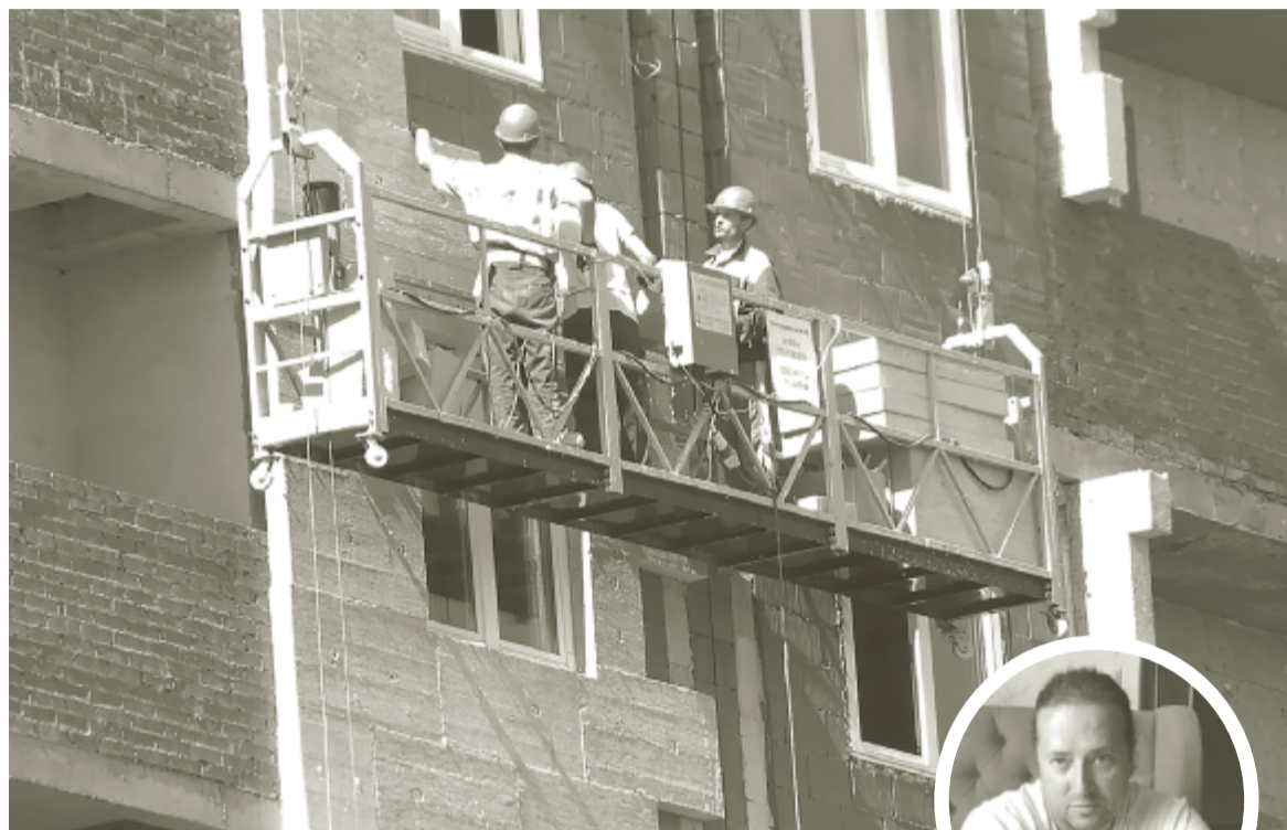
Декабристов, 6. Строительство ведет РСУ-6.
