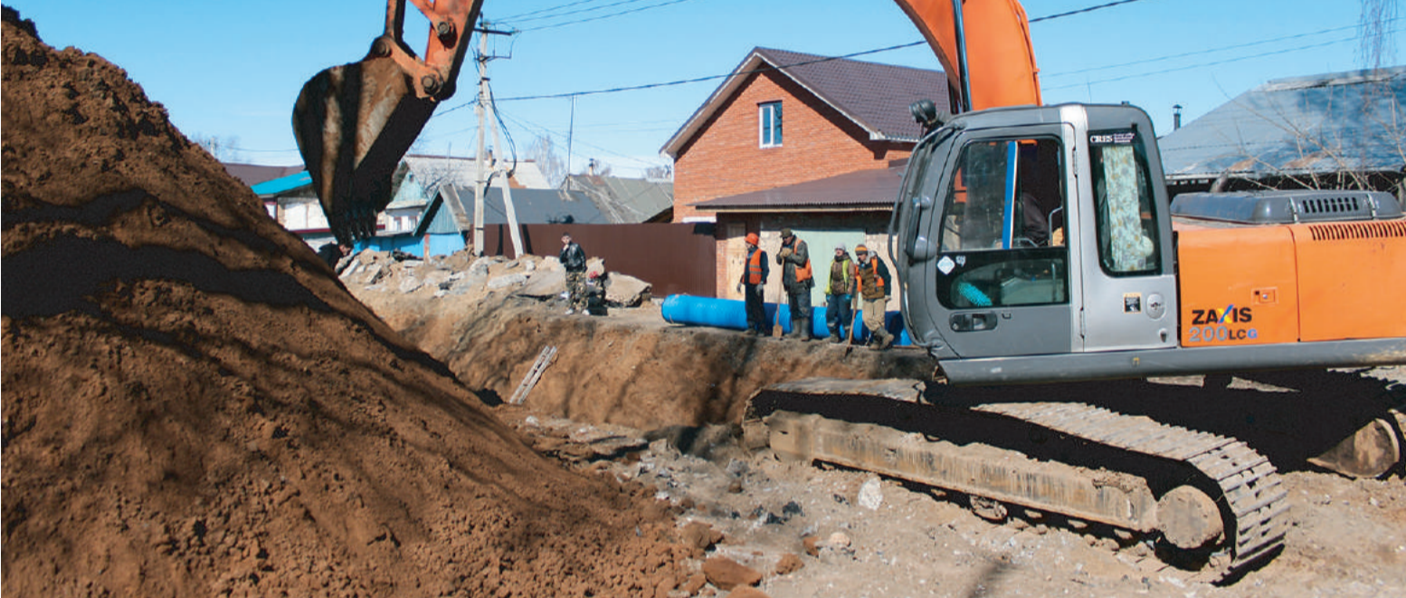
Экскаваторам приходится работать очень аккуратно, поскольку грунт сырой и обваливается
