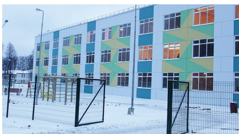
Сроки строительства новой школы несколько затянулись, но главное завершить работы качественно.
