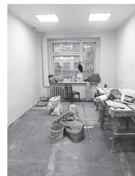
В Чайковском в этом году будут отремонтированы 16 кабинетов участковых
