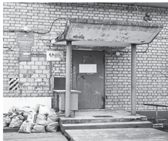
Работы по ремонту участковых пунктов начались в начале октября
