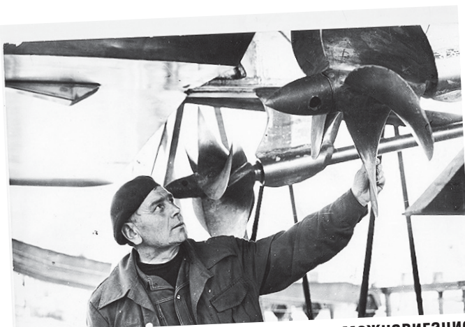
Текущий ремонт судов проводился в межнавигационный период и должен был быть завершён к открытию навигации. Александр Бузмаков на ремонте «Метеора-89».
