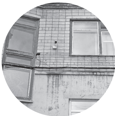
Одна из 12 камер на Новом установлена с «чёрного» входа администрации
