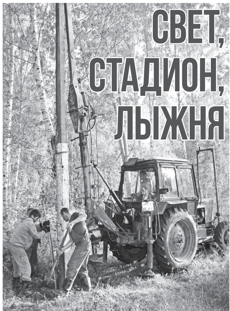
Установка опор освещения и проведение электромонтажных работ
