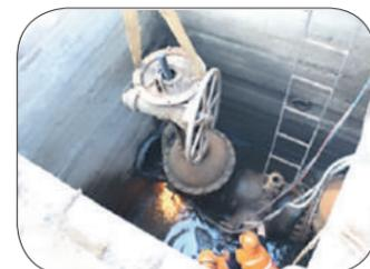
Не так давно на чайковском предприятии «Водоканал» были заменены задвижки, позволяющие путём регулировки снабжать город водой при любых аварийных ситуациях. Старая запорная арматура (задвижки) была установлена на предприятии 55 лет назад и давно проржавела. Благодаря новой арматуре вновь появилась возможность регулировать подачу воды, не оставляя без водоснабжения весь город из-за любого незначительного порыва в сетях.
