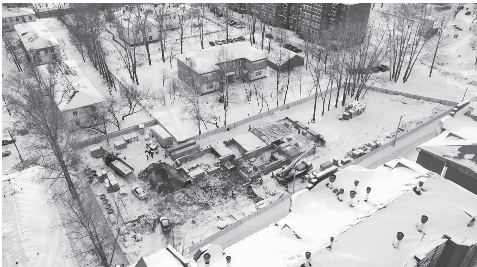
Строители работают над возведением дома ежедневно. Уже установлен фундамент и практически возведён первый этаж
